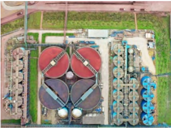
尾矿预处理生产装置
