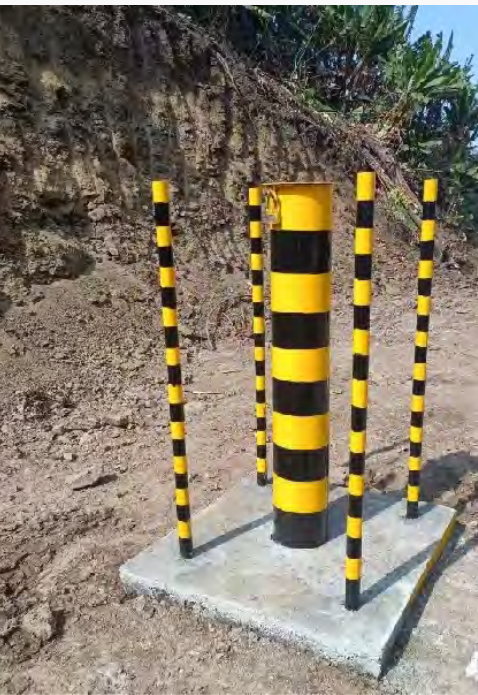
地下水监测井
